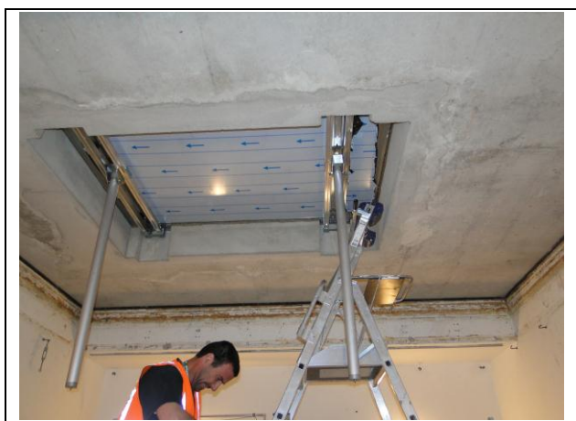
Vue de dessous (vérins pneumatiques)
