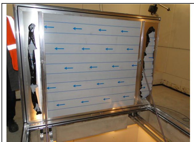
Vue en ouverture (vérins pneumatiques)
