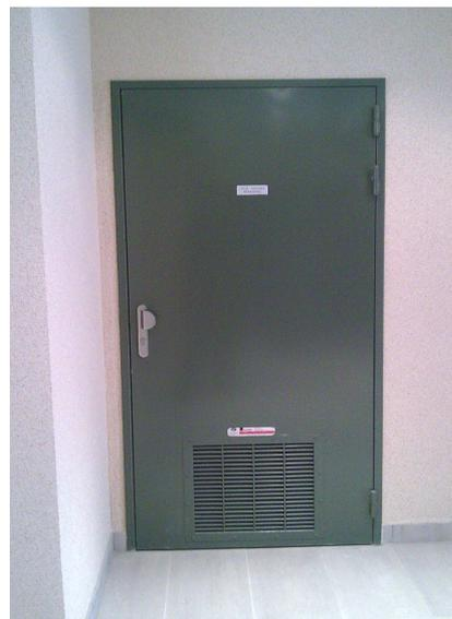
**Fonction:** grille de ventilation qui s'obture automatiquement en cas d'élévation de température, la rendant ainsi coupe-feu.
