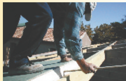
3 Mise en place des languettes CTB-H ou clavettes PVC.
