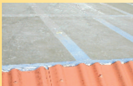
5 Mise en place de la couverture.
