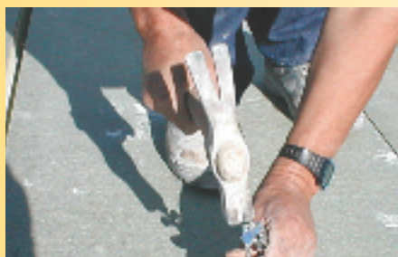
2 Fixation avec pointes torsadées.
