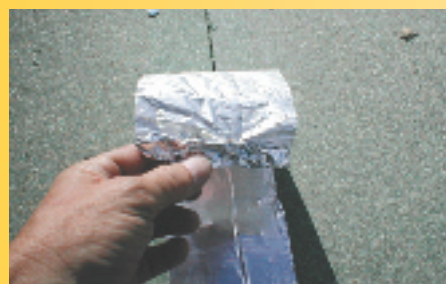
4 Application du ruban adhésif alu assurant l'étanchéité des panneaux.
