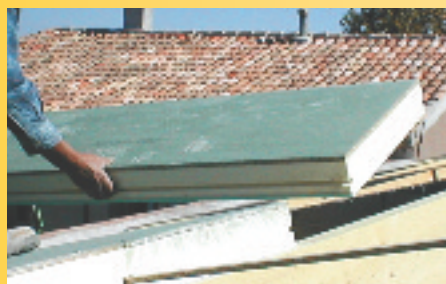
1 Mise en place sur pannes ou chevrons.
