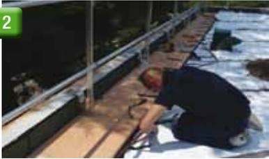
Connexion des nattes **Aquatex** ensemble en bout de ligne. De l'autre côté, installation de bouchons.
