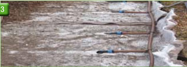
Raccordement des nattes au réseau d'alimentation via une nourrice connectée à l'équipement de programmation (électrovanne, régulateur de pression, filtre et programmeur). Un test de mise en eau doit être effectué à ce stade.
