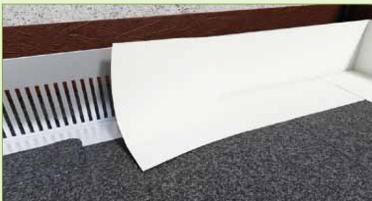
Poser des équerres assez larges de **Soprafiltre** contre les bandes pare-gravier de manière à éviter la fuite du substrat par leurs orifices.
