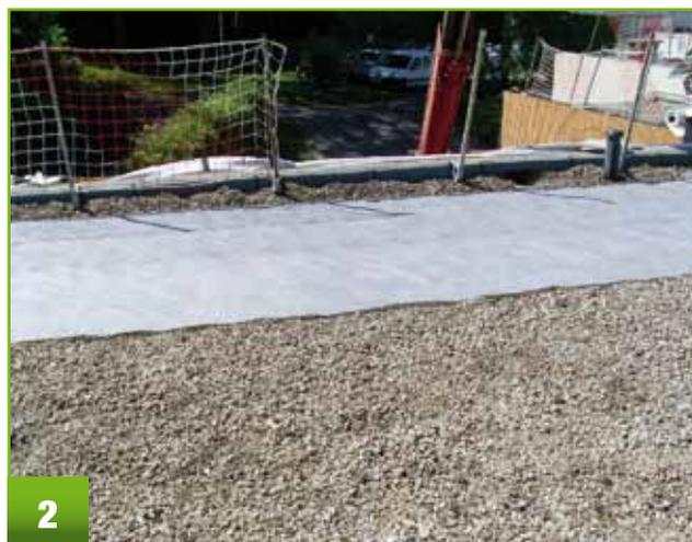
**UN FILTRE SOPRAFLITRE EST PLACÉ SUR LE GRAVILLON**, avec un recouvrement des lés de 5 cm.
