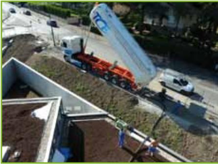
**Les matériaux Sopralithe et Sopraflor peuvent être livrés par camion silo. Une solution permettant un soufflage direct des matériaux sur les toits, rapide, idéale pour les chantiers multi-terrasses et les grandes superficies.**
