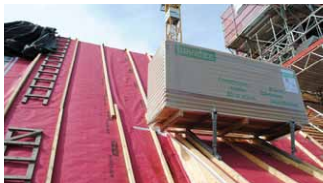
Pose sur toute la surface du lé de sous-toiture PAVATEX ADB.
