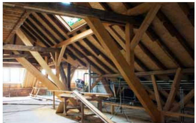
Les vieilles poutres à l'étage supérieur conservées
