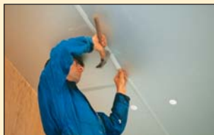
Mise en place du profil T, usage rainé-bouveté.
