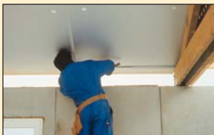
Ajustement de la partie basse du panneau.
