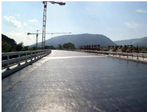
La mise en œuvre s'effectue à la brosse, au rouleau ou à la raclette, sur un support propre et sec, préalablement grenailé. Il est conseillé d'appliquer le produit en une seule couche, à raison de 800g/m<sup>2</sup> environ.
