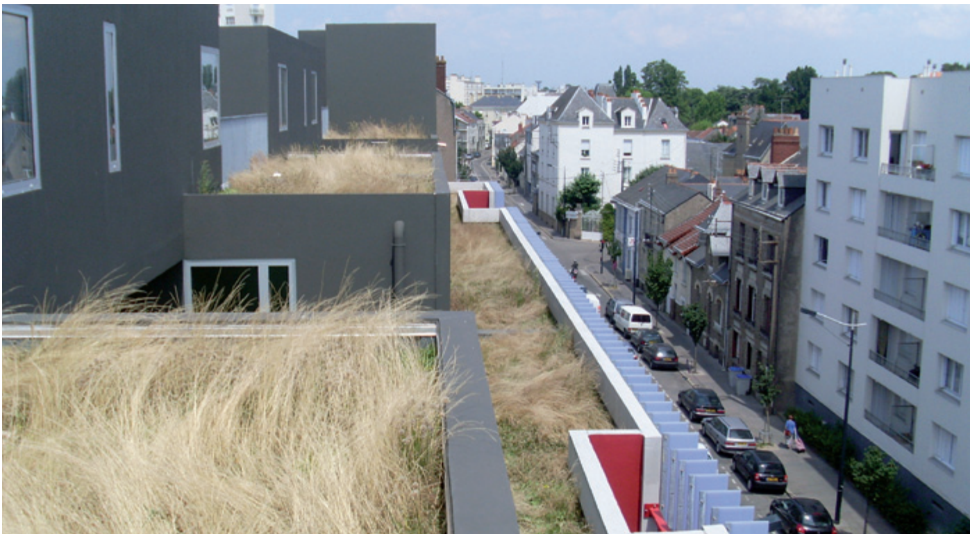
Logements collectifs, Nantes
