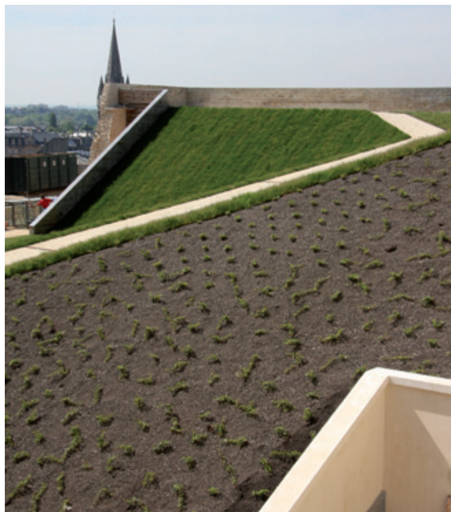
Utilisation de Sopranature sur des pentes de plus de 60 % grâce à des supports de retenue du substrat.
