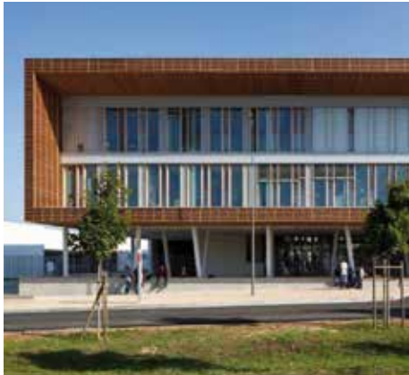
Lycée Kyoto - Poitiers (86) Crédits photo : SCAU architectes®
