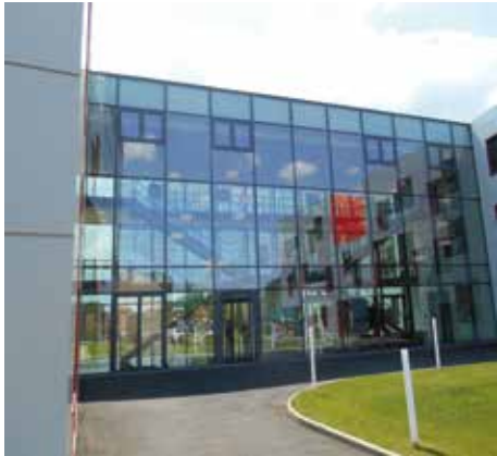
Siège Manitowoc - Ecully (69) Crédits photo : Agence Z Architecture®
