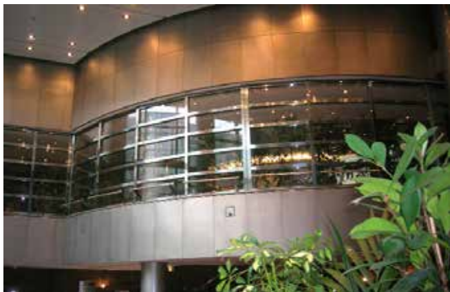
TF1 - Boulogne Billancourt (92) Cloisons vitrées à facettes EMV
