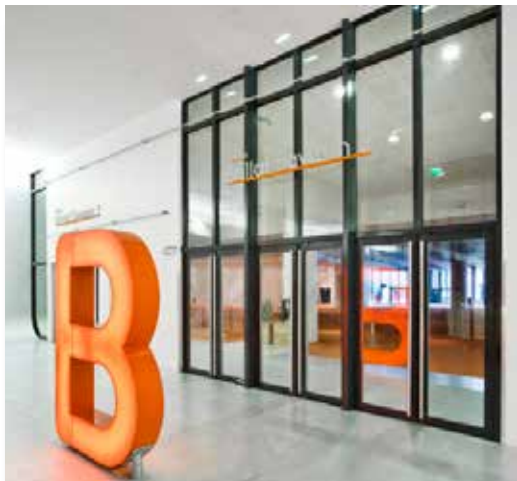
CNIT - La Défense (92) Cloisons EMV de grande hauteur
