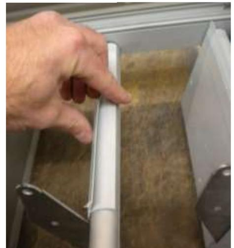
**Etape 5** : Mettre en place l'isolant lame en emboîtant correctement en partie basse.
