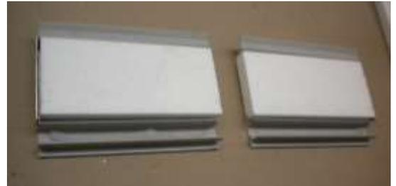
**Etape 4** : Préparer les isolants lame en appliquant un cordon de silicone à l'intérieur de la réservation de la partie arrondie sur toute la longueur du profil PVC
