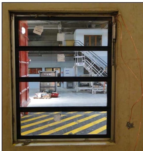
Vue côté intérieur
