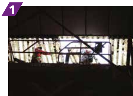
1 Création de la trémie en démontant seulement 3 plaques
