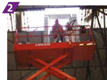
2 Remplacement de l'ancien appareil en 1h30
