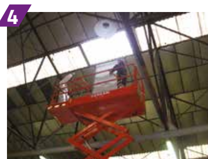
4 Montage depuis l'intérieur de la trémie
