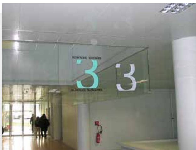
écrans de cantonnement fixes vitrés SMOKESTOP
