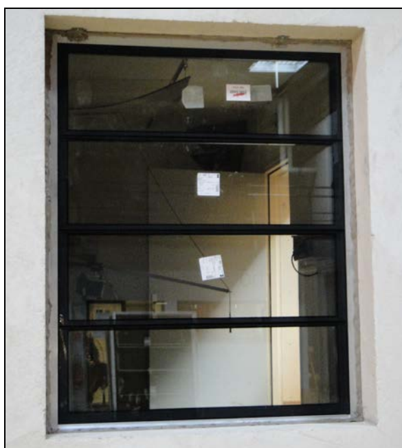
Vue côté extérieur
