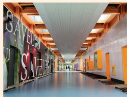
Figure 3.2 - Les lanternes filants sont un classique des équipements de toitures industrielles et tertiaires.
