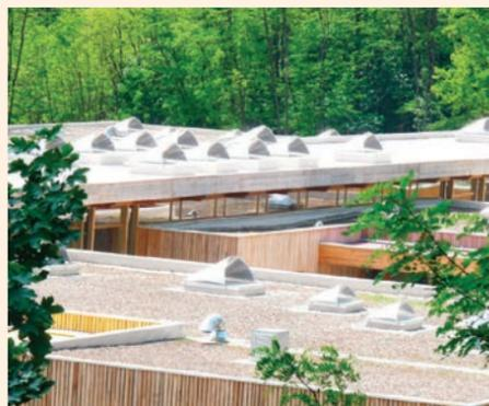
Figure 3.4 - Appports lumineux par puits de lumière sur le toit.
