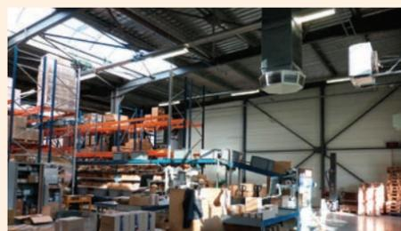
Figure 3.6 - Les systèmes de ventilation adiabatique assure une ventilation permanente efficace et une fonction de rafraîchissement à très faible coût global.
