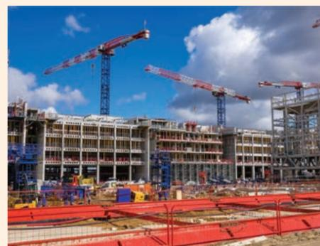
Figure 3.9 - L'ENS de Paris-Saclay en chantier. En façade, des vantaux régulent la ventilation naturelle de la plus grande partie de cet ouvrage (Renzo Piano Architecte).
