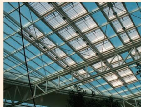
Figure 3.3 - Les verrières permettent de réaliser des volumes tampons profitables en termes thermiques.
