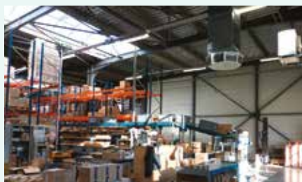
Figure 3.6 - Les systèmes de ventilation adiabatique assure une ventilation permanente efficace et une fonction de rafraîchissement à très faible coût global.
