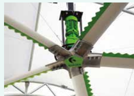
Figure 3.5 - Les ventilateurs dédiés à la déstratification ont fait leurs preuves en industrie et en logistique.
