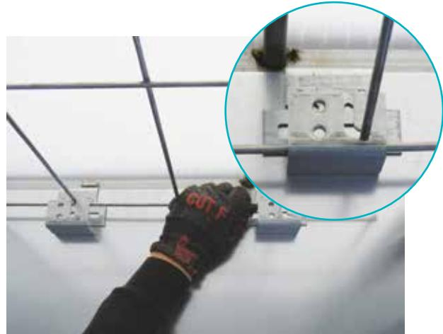
**5** Vérifier le bon positionnement du crochet de verrouillage du vérin
