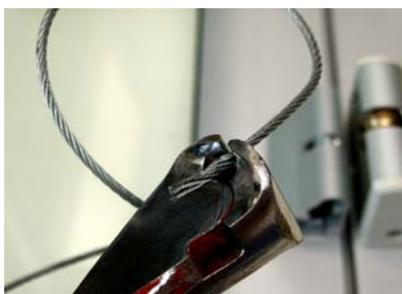
2) Placer la gaine thermo-rétractable et chauffer le bout du câble.
