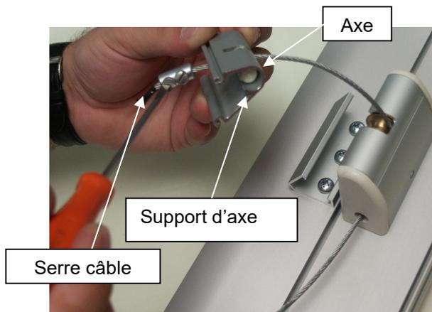
10 – Fixer le câble suivant le schéma
