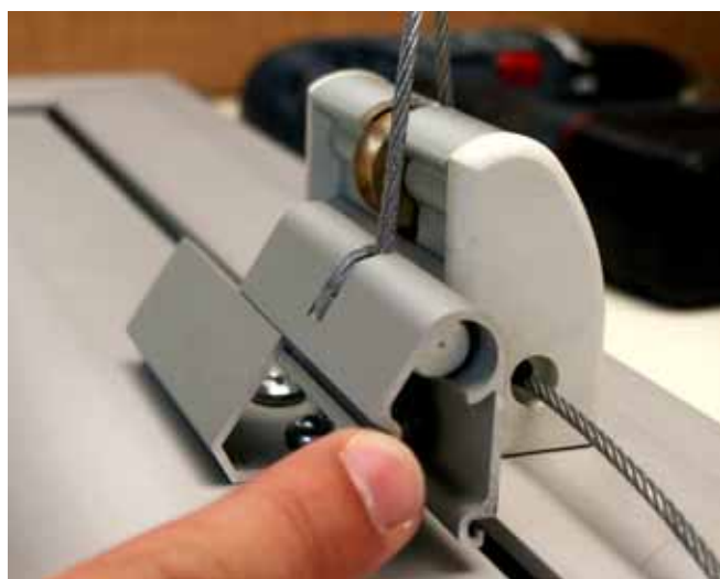
11- Monter le support d'axe sur l'ouvrant
