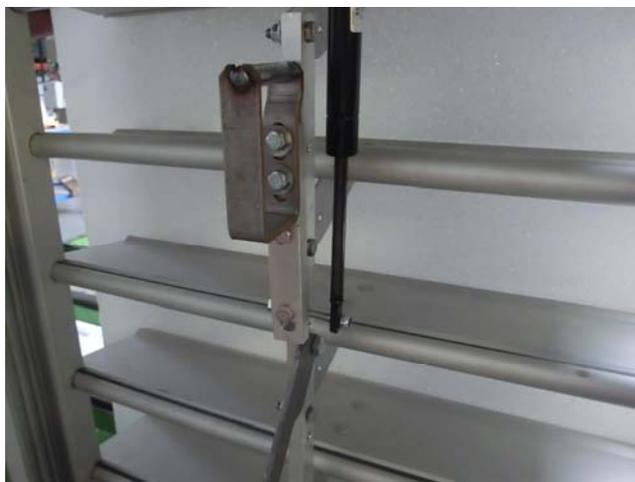
AIRLAM V2 en position de sécurité (ouvert), démonter le levier de réarmement manuel et le système « gâche ».
