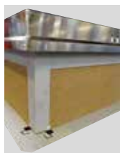
ISOLANT INVERSÉ + TÔLE COLAMINÉE pour souder la membrane PVC
