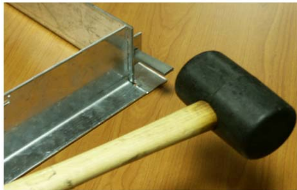
4 – Une fois le cadre constitué, engager les clavettes (au marteau) suivant la figure ci dessus.
