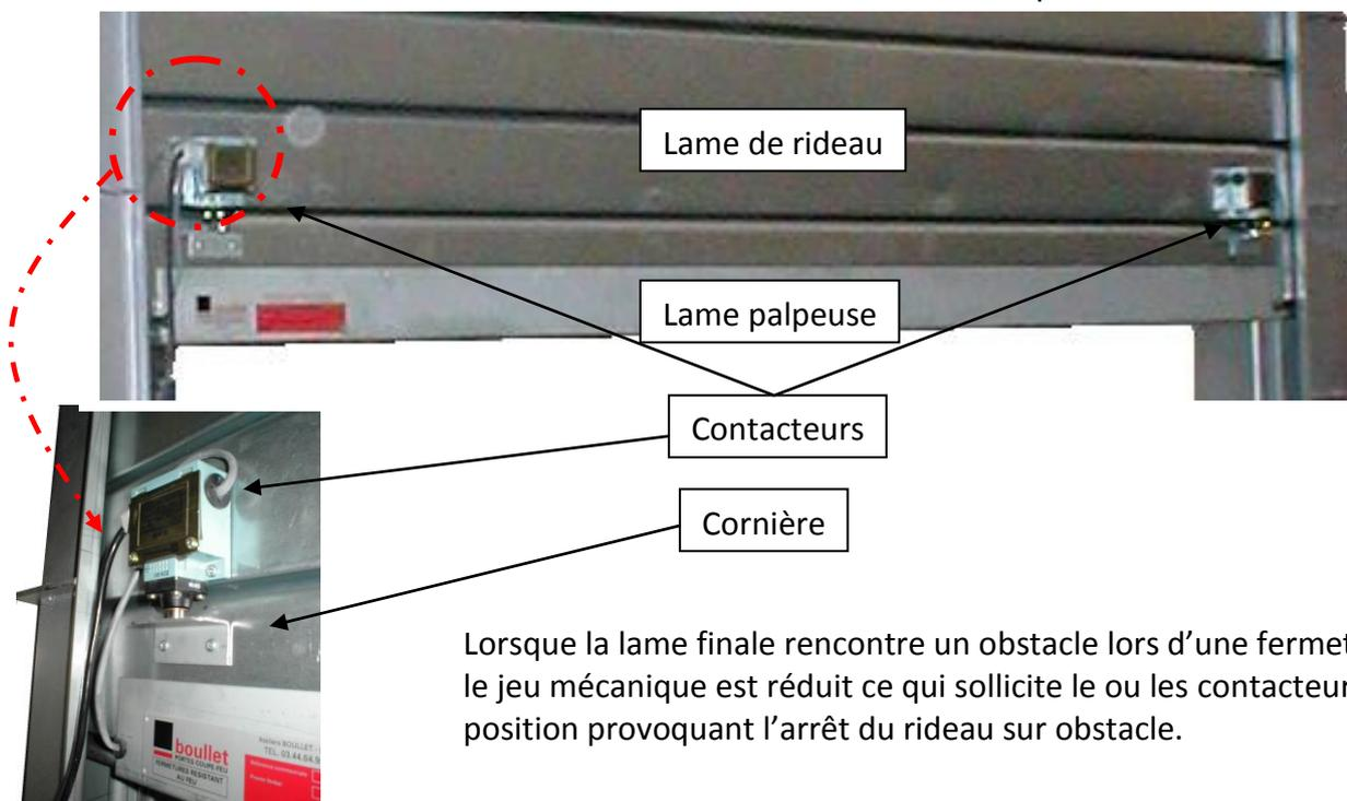
Un câble spirale assure la liaison électrique entre la lame palpeuse et l'armoire de gestion DAS.
