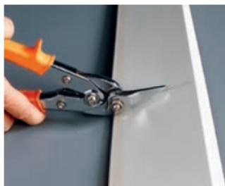
Pour l'étanchéité finale, découper une pièce ronde FLAGON TPO, avec un excès de 2 cm pour le chevauchement et le joint de soudure.
