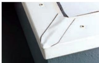
Après la pose de la bande de protection, fixer le profilé de tôle composite découpé.
