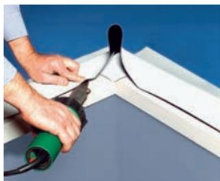
Agrafer le lé d'étanchéité FLAGON TPO au profilé de tôle composite sur le plan vertical, partant de 1 cm du bord, de sorte que le matériel en excès forme un pli plat au bord.
