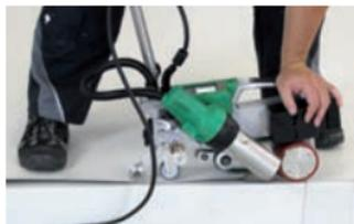
Les joints de dilatation des profilés de tôle composite doivent être soudés avec le lé sans support FLAGON EP/S ou le lé avec renforcement de voile de verre FLAGON ECO. Le lé avec garniture de renfort FLAGON PREMIO n'est pas approprié en ce sens. La bande de recouvrement ne doit être soudée de façon homogène qu'aux bords. Sur la zone de jointure des profilés de tôle composite, la bande de lé doit rester soudée pour la réception d'éventuels mouvements.
