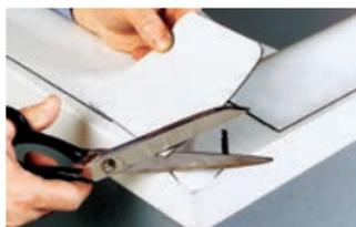
Pour le couvercle d'extrémité, découper une pièce moulée ronde FLAGON TPO pour l'étanchéité finale avec un excès de 2 cm pour la couverture et le joint de soudure.
