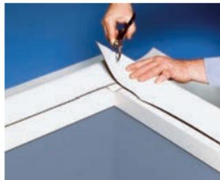
Raboter les lignes de chevauchement sur la bande de découpage. Souder par points, pré-souder et post-souder la bande de bordure inférieure sur la surface horizontale du profilé de tôle composite.
