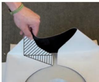
Poser la bande FLAGON TPO sur l'écoulement de l'eau de toit et agraffer à points afin qu'il en résulte quatre plis plats. Couper le marquage dans le pli plat.
