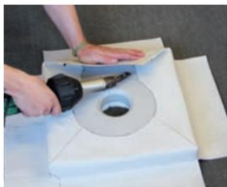
Fermer le pli plat par soudage et souder la bande sur l'écoulement de l'eau de toit. Répéter cette opération en ce qui concerne les autres plis plats.
