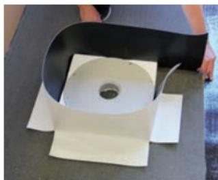
Souder les bandes FLAGON TPO sur le pare-vapeur bitumineux au moyen d'un appareil de soudage à main. Lors de l'opération de concentration à l'arrière, chevaucher la soudure longitudinale de 8 cm et souder complètement les bandes FLAGON TPO.
