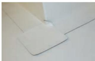
Découper un morceau rectangulaire de FLAGON TPO afin de compléter la partie manquante dans la surface. Arrondir, chauffer et dilater sur un côté.
