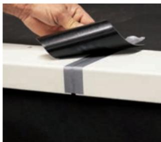
Recouvrir les zones libres entre les extrémités avec une bande de coupe de 12 cm de large et souder sur chaque côté 3 cm des profils de tôle composite.
