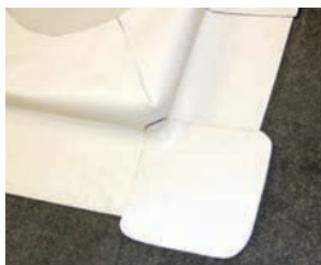
Dans la zone du pare-vapeur, compléter les angles avec un morceau de FLAGON TPO et procéder par analogie pour les angles externes sans pièces moulées.
