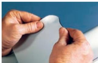
Poser le lé d'étanchéité sur un côté du mur de l'angle externe. Entailler le lé d'étanchéité jusqu'au coin de l'angle. Rabattre l'excès sur le mur opposé. Souder par points, pré-souder et souder le lé d'étanchéité sur la surface horizontale.
