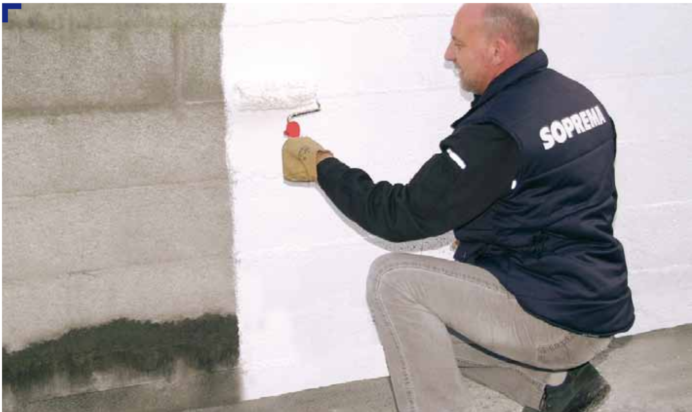
Application sur mur en parpaing.
