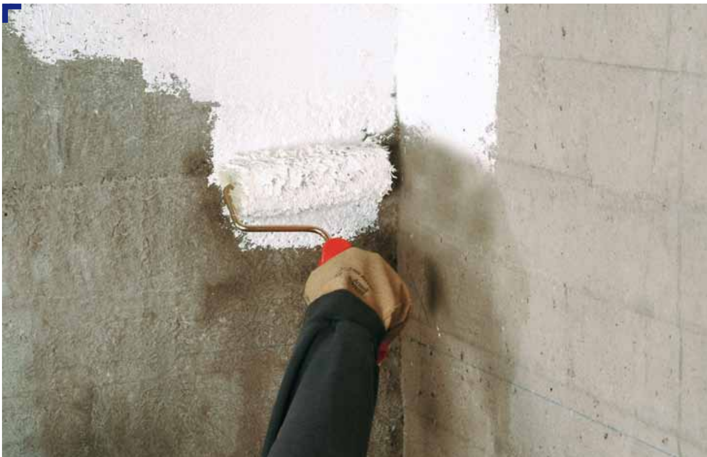
Application sur mur en sous-sol.
