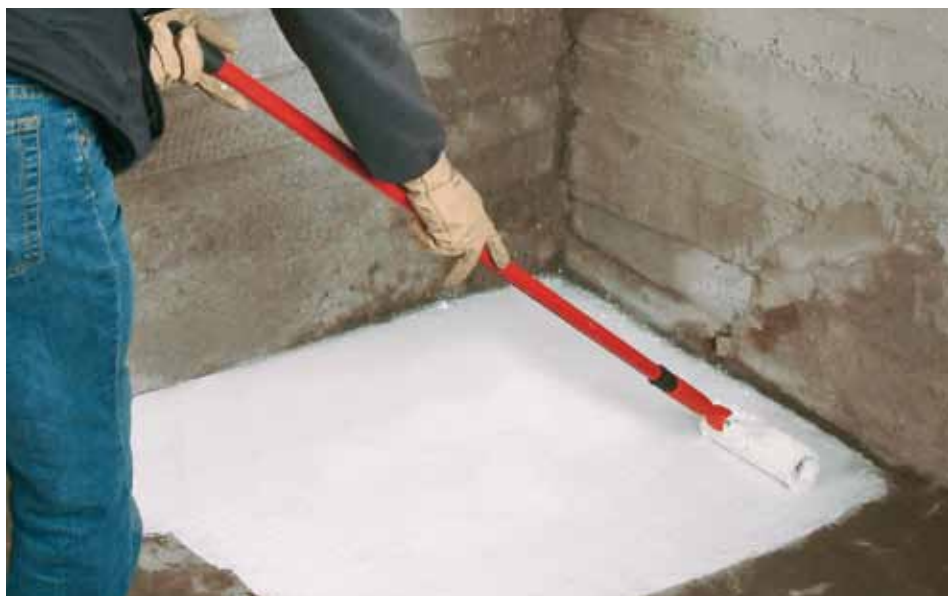
Application sur sol en ciment.
