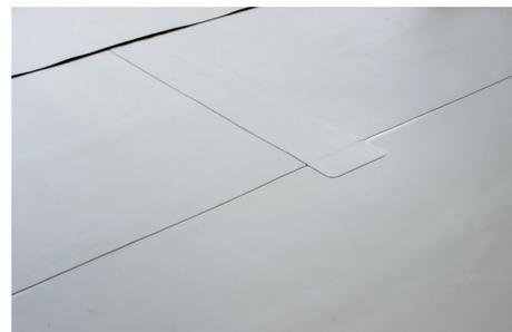
**FLAGON Eco F** eignet sich zur vollflächigen Verklebung auf geeignetem Untergrund. Für eine fachgerechte Lagesicherung muss hierbei der gesamte Dachschichtenaufbau bis zur Tragschale untereinander verklebt werden. Die FLAGON Eco F wird lose und faltenfrei auf der abzudichtenden Dachfläche mit 8 cm Nahtüberlappung ausgelegt und sollte stramm ausgerichtet werden. Die ausgelegten Bahnen sollten dann mindestens 30 Minuten ausliegen, um sich so der Umgebungstemperatur
