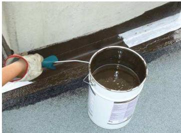
Après application d'une fine couche de FLASHING TP sur un support nettoyé, appliquer ALSAN VOILE FLASHING sur la résine liquide. Veiller à ne former aucun pli ou bulle d'air en appliquant une légère pression sur la toile à l'aide d'un rouleau à poils moyens. Une première puis une deuxième couche de FLASHING TP vont recouvrir entièrement l'ALSAN VOILE FLASHING.
