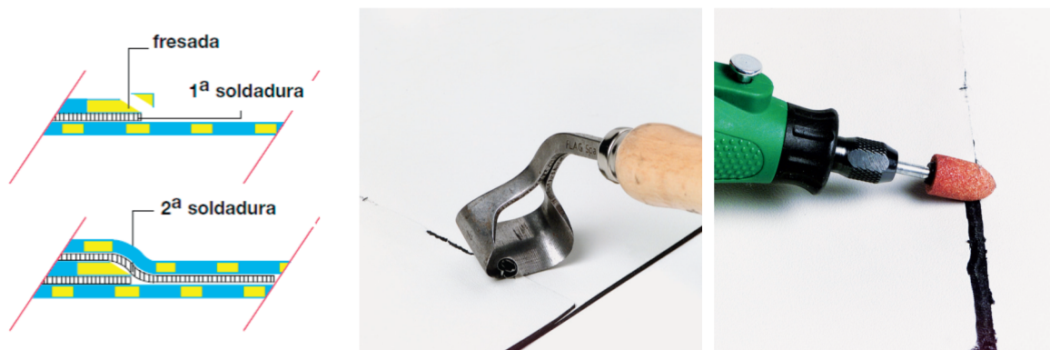
Detalle de cómo achafflanar la lámina inferior con fresa o granador.
