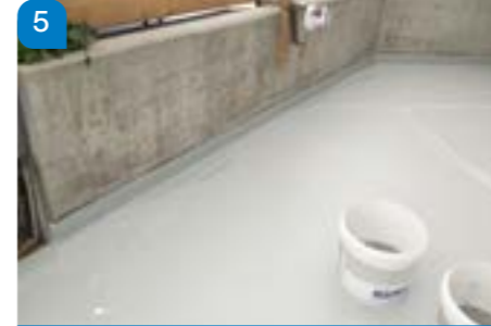
Mise en place de la couche d'usure avec le mortier autolissant Alsan PMMA 870 RS pour la surface et Alsan PMMA 770 TX pour les bords.
