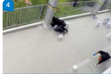
Raccordement des joints de natte avec Alsan PMMA 770 TX et le voile spécial et réalisation des détails et raccords.
