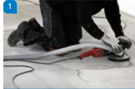
Dépose de l'ancien revêtement (carrelage par ex.) et préparation du support par ponçage.
