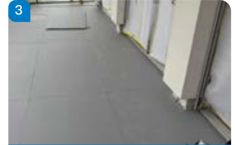
Pose de la natte Vaporex et ajustement des plaques de ventilation pour permettre l'évacuation de l'humidité.
