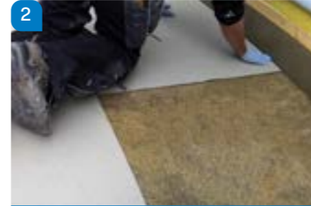
Application en plein du primaire d'imprégnation Alsan PMMA 170 pour le collage de la natte Vaporex.
