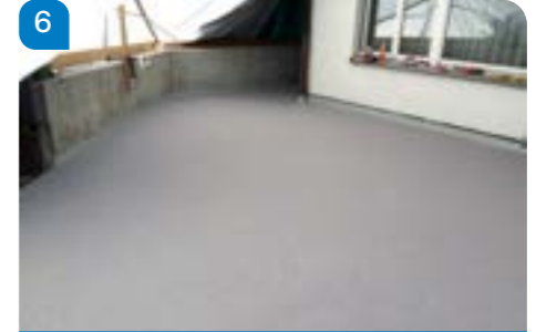
Scellement de la surface avec Alsan PMMA 970 F. L'esthétique de la surface peut être améliorée par le saupoudrage de paillettes Alsan Chips.
