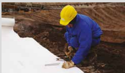
3- Mise en œuvre des fixations latérales.
