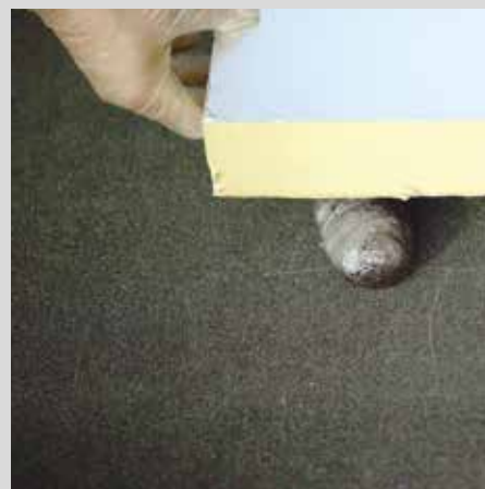
6- Posez les panneaux d'isolation sur les cordons de colle et les plaquer au support.
