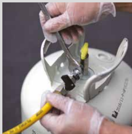
3- Fixer le tuyau au canister et ouvrir la valve.
