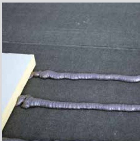
5- Appliquez directement sur le support des cordons uniformes de 30 mm de largeur en maintenant le canon du pistolet à 1 cm de la surface. Appliquez des cordons parallèles tous les 20 cm.
