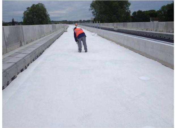
Les aléas climatiques et la pollution entraînent une diminution des qualités de réflexion du produit. Il est à noter PARUVEL conserve son efficacité pendant environ trois mois, au-delà il est nécessaire d'appliquer une nouvelle couche ou de procéder à la mise en œuvre de la protection définitive.
