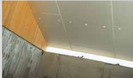
5- Sous-toiture en Thermagri® .
