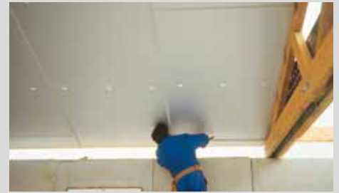
3- Ajustement de la partie basse du panneau.
