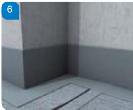
Rimuovere immediatamente il nastro di copertura quando la resina impermeabilizzante è ancora umida. Se il materiale viene rimosso troppo tardi e ha già reagito, può staccarsi lungo i bordi. Se il materiale si è già indurito, potrebbe essere necessario rimuovere il nastro adesivo con un cutter, rischiando però di danneggiare l'impermeabilizzazione appena ultimata.
