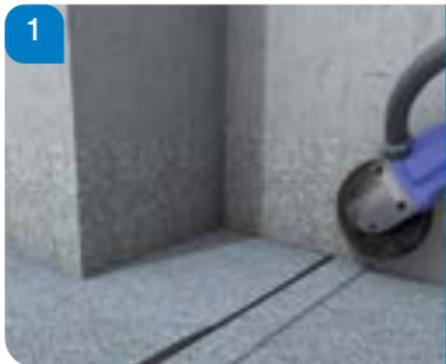
Prima di iniziare i lavori di impermeabilizzazione, rettificare l'area del raccordo in materiale minerale. Eliminare le scaglie di ardesia staccatesi dalla membrana bituminosa tramite una spazzola metallica. Coprire con nastro di copertura rivestito di PE. Utilizzare il nastro di copertura anche per separare le giunzioni o per passaggi difficili tra materiali. Infine pulire accuratamente la superficie con un aspirapolvere.
