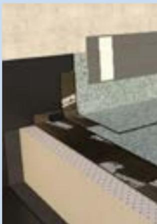
Se la striscia di copertura viene sostituita con resina liquida su un sottofondo adatto, a fronte di un'adeguata preparazione del sottofondo il risultato è un risvolto altamente resistente alle infiltrazioni posteriori, a bassa manutenzione e poco costoso, in grado di resistere a forze di trazione estreme e impedire lo scivolamento della membrana bituminosa anche a temperature elevate.
