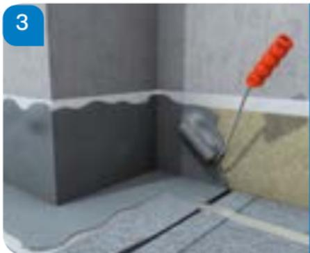
Dopo l'indurimento del primer, applicare lo strato di incorporamento. Applicare una quantità sufficiente di resina impermeabilizzante Alsan PMMA 770 TX (circa  $1,5 \text{ kg/m}^2$ ) soprattutto nei passaggi tra materiali, negli angoli o sulle superfici verticali.
