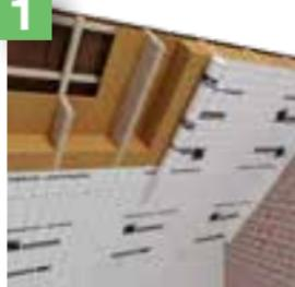
Rol het membraan zorgvuldig uit en bevestig het membraan met nietjes om de 10 à 15 cm (gebruik best nietjes van 10 mm breed en 8 mm lang). Laat het membraan langs de randen minimum 4 cm doorlopen zodat het membraan rondom rond extra kan bevestigd worden voor een optimaal luchtdicht resultaat. Zorg dat de verschillende stroken een overlap van minstens 10 cm hebben, gebruik hiervoor de handige markeringen op de folie.
