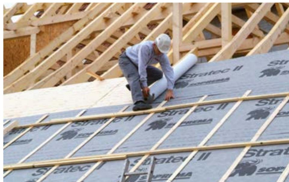
Un écran de sous-toiture est une feuille souple déroulée sous les petits éléments de couverture : ardoises, tuiles, bardeaux, ...
