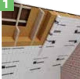
Rol het membraan zorgvuldig uit en bevestig het membraan met nietjes om de 10 à 15 cm (gebruik best nietjes van 10 mm breed en 8 mm lang). Laat het membraan langs de randen minimum 4 cm doorlopen zodat het membraan rondom rond extra kan bevestigd worden voor een optimaal luchtdicht resultaat. Zorg dat de verschillende stroken een overlap van minstens 10 cm hebben, gebruik hiervoor de handige markeringen op de folie.
