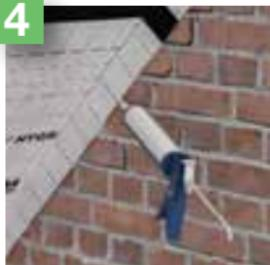
Breng de PAVABOND-kit aan voor een luchtdichte afsluiting langs de randen van het membraan.
