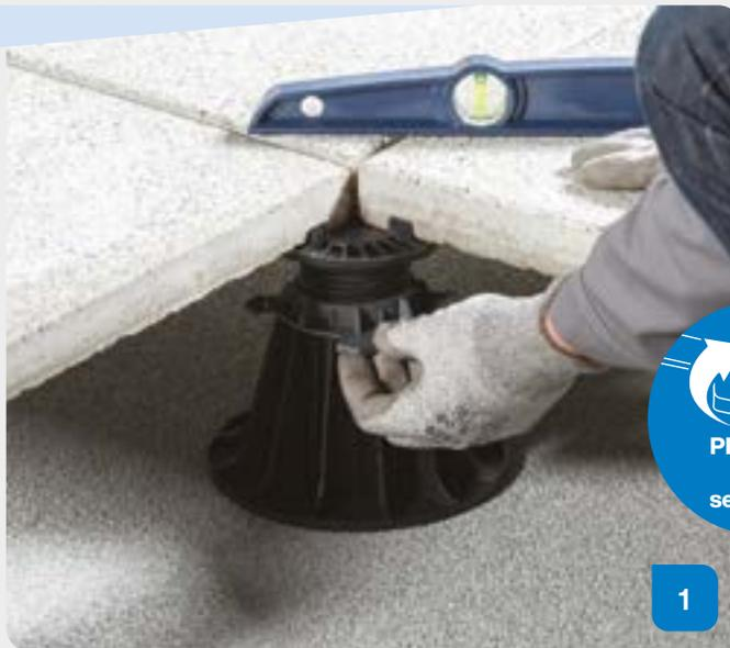
Scegliere un supporto sul dado della pedana, a seconda dello spessore da regolare (spessore di 1, 2, 3 o 4 mm).
