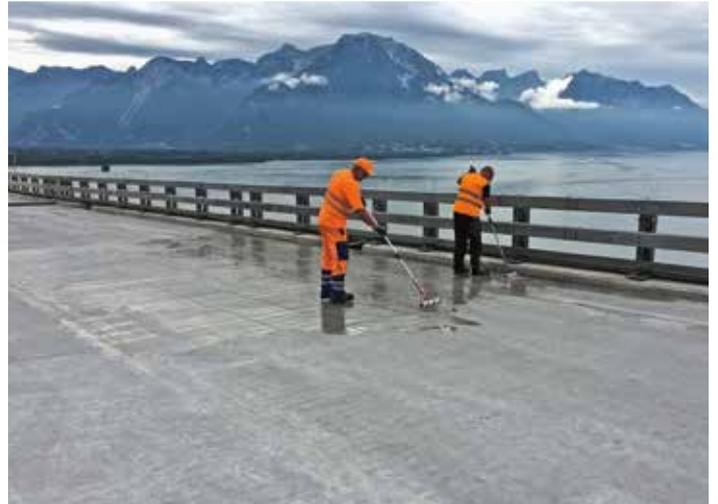
Reku-Siegel ist ein nach SNV 640450, ZTV ING; RVS und EN 14695 geprüftes System zur Erstellung einer Versiegelung auf Brücken und Parkdecks auf der Basis von PMMA.
