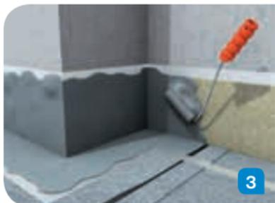
Nach einer Wartezeit von ca. 20 min Einbettschicht auftragen. Vor allem bei Materialübergängen, im Eckbereich oder bei vertikalen Flächen ausreichend Material vorlegen (ca. 1,5 kg/m<sup>2</sup>).
