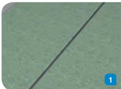
1. Abdichtungslage über der Gebäudefuge aufschneiden.
