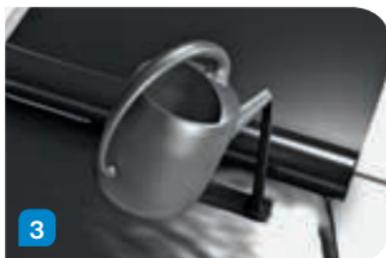
SOPRALEN EGV3 PLUS als erste Lage vollflächig mit Heissbitumen auf die Wärmedämmung eingiessen. (Verbrauch ca. 2.2 kg/m<sup>2</sup>).
