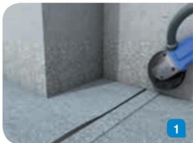
Vor Beginn der Abdichtungsarbeiten mineralische Anschlussbereiche anschleifen. Lose Schieferschuppen der Bitumenbahn mittels Drahtbürste entfernen. Mit PE-beschichtetem Abdeckband abkleben. Abdeckband auch zur Entkopplung von Fugen oder heiklen Materialübergängen verwenden.
