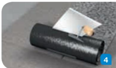
Den Überlappungsstoss nun mit einem kleinen Brenner (Durchmesser max. 4 cm) dichtverschweissen. Überlappung 12 cm (2 cm Alu + 10 cm Schweissnaht).
