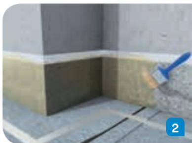
Fläche im Bedarfsfall gemäss Untergrundtabelle grundieren. Beschieferte Bahnen müssen nicht grundiert werden. Grundierung mittels Roller oder Pinsel auftragen.
