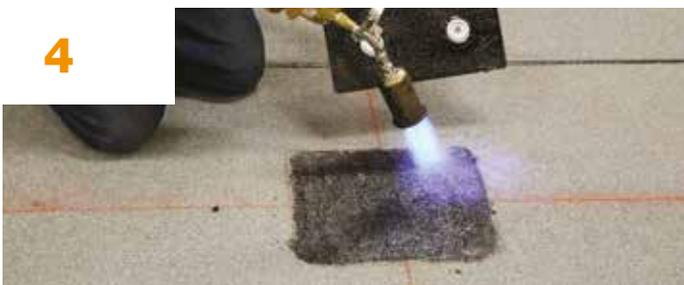
Calentad el área donde se instalará el soporte con el soplete.
