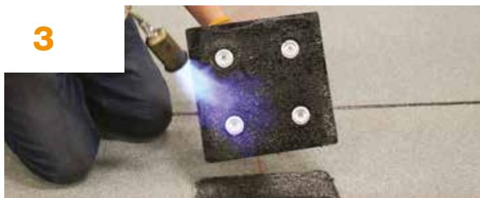
Calentad el film antiadherente de la base del soporte con el soplete.
