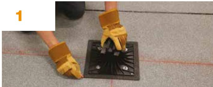
Una vez finalizada la instalación de la membrana en la cubierta, marcad la ubicación del **SOPORTE SOPRASOLAR® FIX EVO TILT** en la capa superior de la impermeabilización según el plano proporcionado por **SOPRASOLAR®**.
