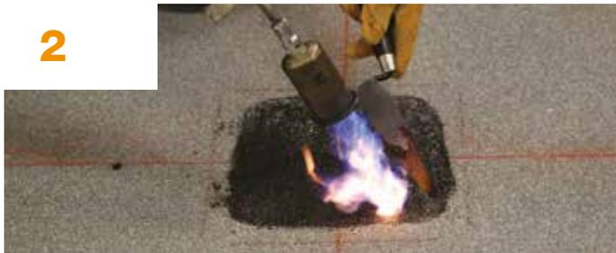
Impregnad con el soplete la pizarrilla de la impermeabilización en el área donde se instalará el soporte.
