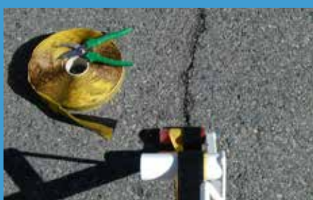
Preenchimento de fissuras com asfalto (Stratos R2 com ferramenta de instalação)
