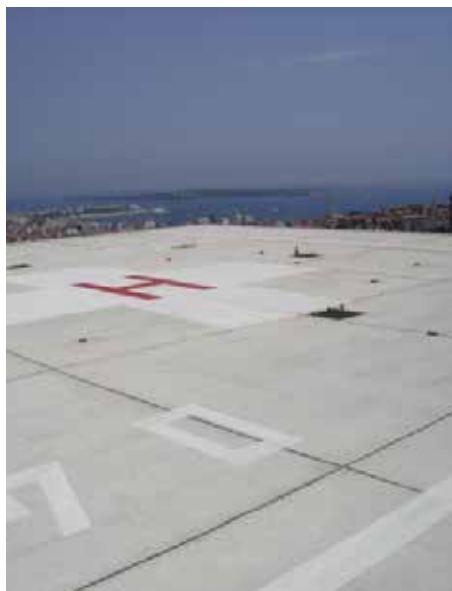
Juntas resistentes ao querosene num heliporto (Stratos R4)
