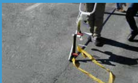
Preenchimento de fissuras com asfalto (Stratos R2 com ferramenta de instalação)
