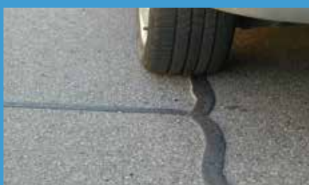
Preenchimento de fissuras com asfalto frio (Stratos R2)
