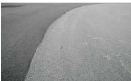
União de asfalto/asfalto (Stratos R1)
