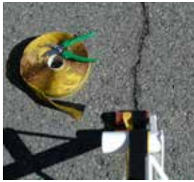
Preenchimento de fissuras Banda prefabricada
