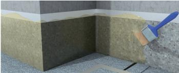
2. Si nécessaire selon le tableau des supports, appliquer une couche de primaire. Les lés ardoisés n'ont besoin d'aucune couche de primaire. Appliquer le primaire à l'aide d'un rouleau ou d'un pinceau.
