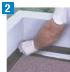
2 Verstevigingsvlies inwerken met ALSAN FLASHING JARDIN.
