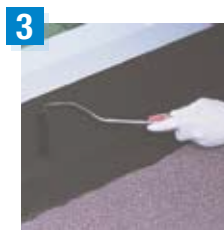
3 Aanbrengen van twee lagen ALSAN FLASHING JARDIN.
