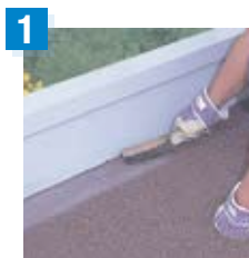
1 Verwijderen van de losse leischiffers met een staalborstel.
