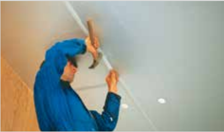
4- Mise en place du profil T, pour usinage rainé-bouveté.
