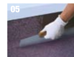
05 Perfekt och jämn sömlös yta med skifferflis eller med CURAL aluminiumfärg
