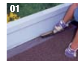
01 Avlägsna lösa skifferflagor med en stålborste
