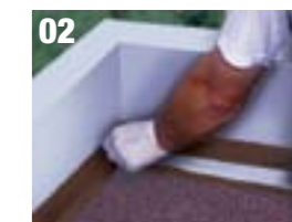
02 Montera polyesterförstärkningsmaterial med Alsan Flashing
