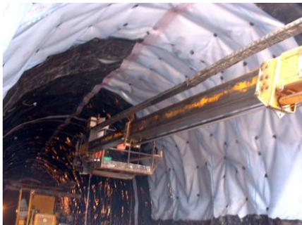
La membrana FLAGON BT/I può essere utilizzata in sistemi impermeabilizzanti monostrato, compartimentati o no, e come strato d'impermeabilizzazione di sistema Vacuum Flag.
